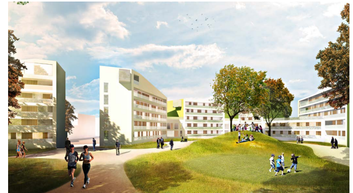
Näkymä Kolmiapilan sisäpihalta
